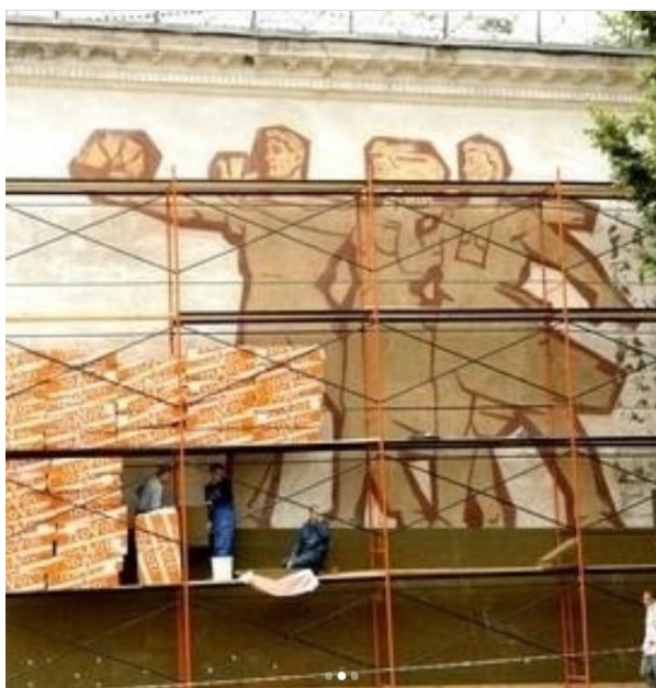
Утепление торца здания по адресу ул. Ленина, д.72.
